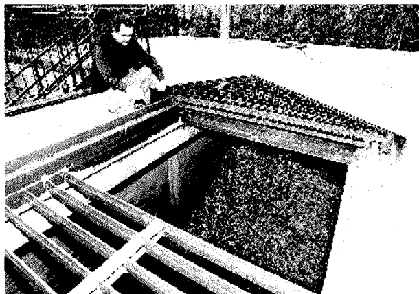
Il deposito di cippato utilizzato per riscaldare la Curia torinese
